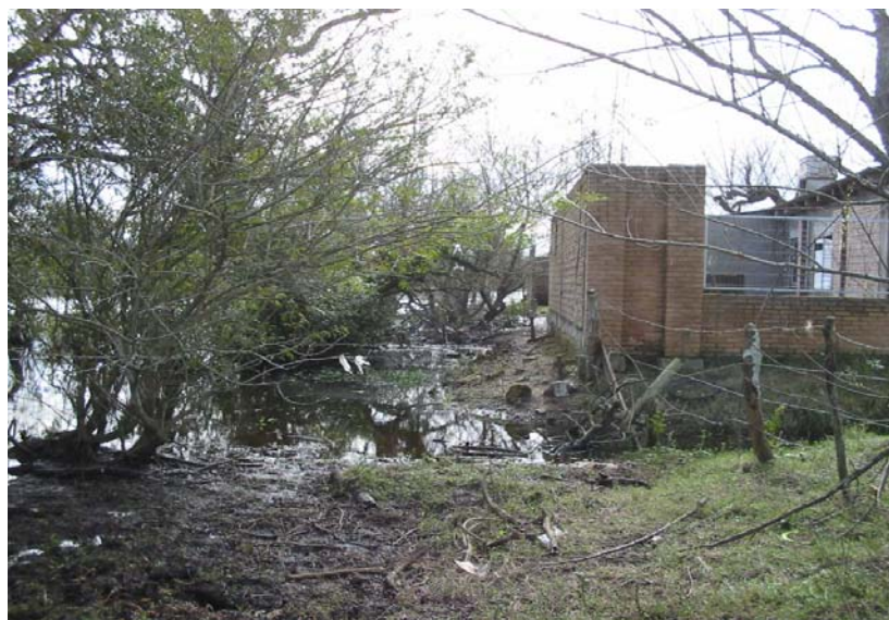
Figura 7: Construção irregular, em área de preservação permanente e em aterro sobre o leito do arroio.
