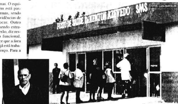
Para poder prestar um melhor atendimento para a comunidade do Cassino o PS conta com um gerador de energia elétrica
