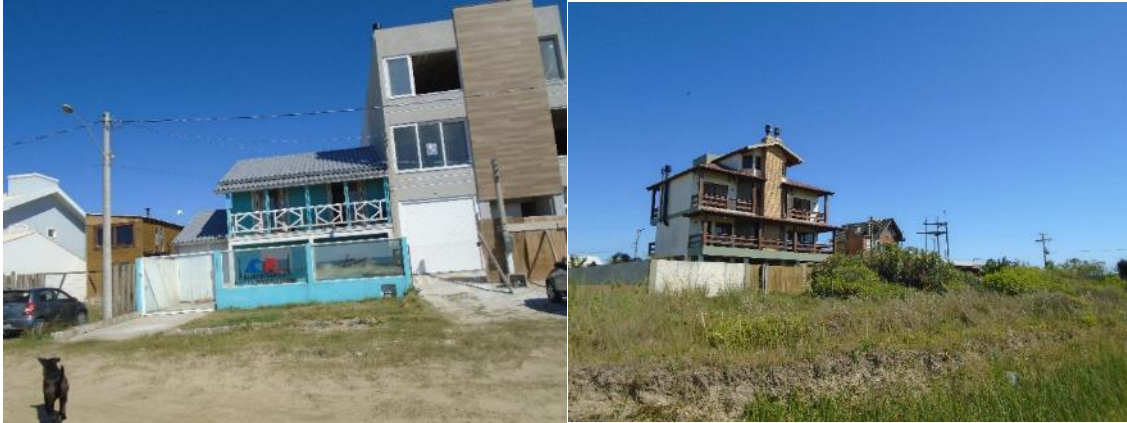
FIGURA 48. (a) Quadra construída na Avenida Nova Beira-mar - na imagem é possível visualizar a loja de equipamento de surf e o prédio em construção. (b) Terrenos da segunda quadra da Avenida Nova Beira-mar - embora pareça que há construções nessa área, as casas que aparecem nas imagens são do terreno atrás (na frente os terrenos estão sem construção).
