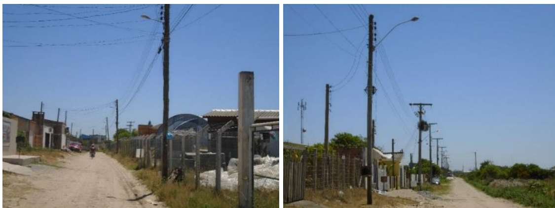
FIGURA 61. (a) Avenida Cassino: à direita, a EMA; à esquerda, as áreas construídas na primeira quadra da localidade Atlântico Sul; (b) Perspectiva da Avenida Cassino a partir da última quadra do Atlântico Sul, em direção à EMA.
