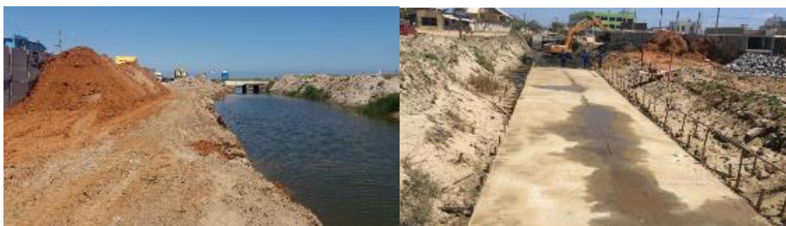
FIGURA 32. Obras de drenagem e pavimentação que estão sendo desenvolvidas na Rua do Riacho. Fonte: PMRG.
