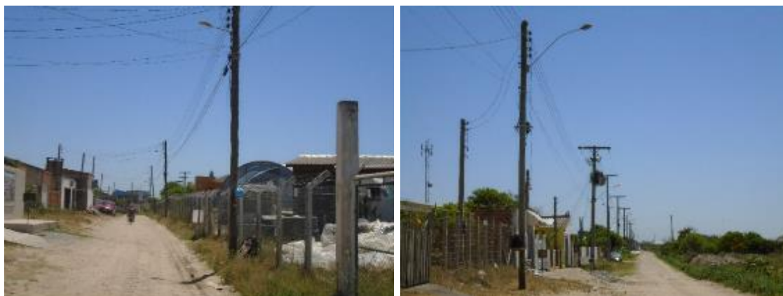
FIGURA 58. (a) Avenida Cassino: à direita, a EMA; à esquerda, as áreas construídas na primeira quadra da localidade Atlântico Sul; (b) perspectiva da Avenida Cassino a partir da última quadra do Atlântico Sul, em direção à EMA.
