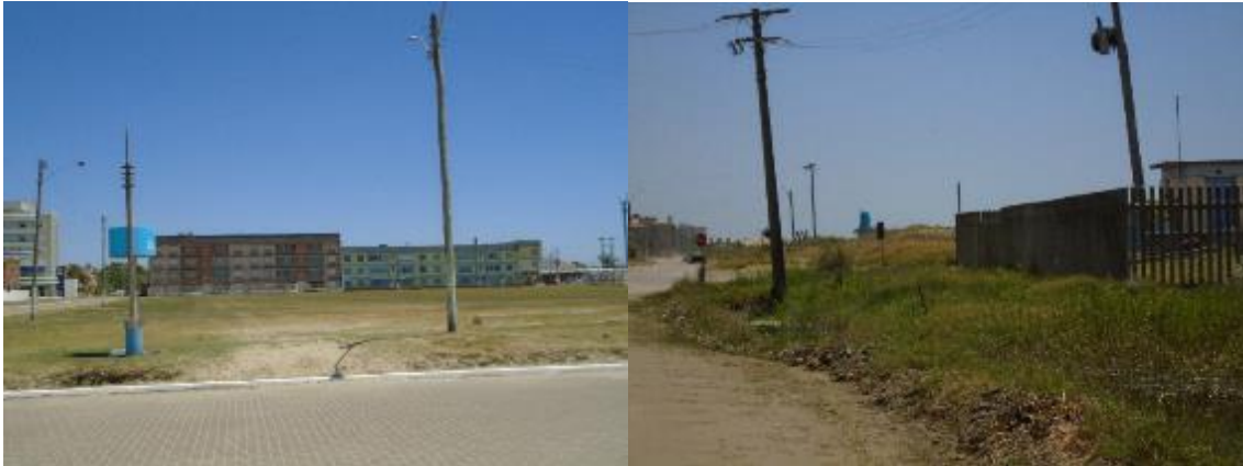
FIGURA 54. (a) Campo de futebol, onde são disponibilizadas duchas para banhistas, também é utilizado para acampamento em eventos e com centro de eventos. (b) Estação Elevatória da Corsan em área de dunas. Em azul, ao fundo, é possível ver a estátua da Iemanjá.
